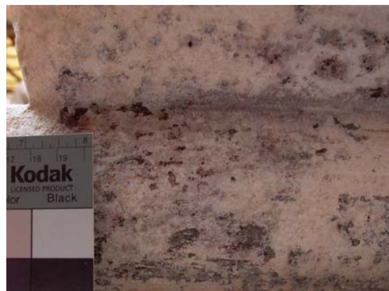
Figuras 6 e 7. A alteração cromática rosa clara, sobre o leito, num local mais próximo da mitra.
